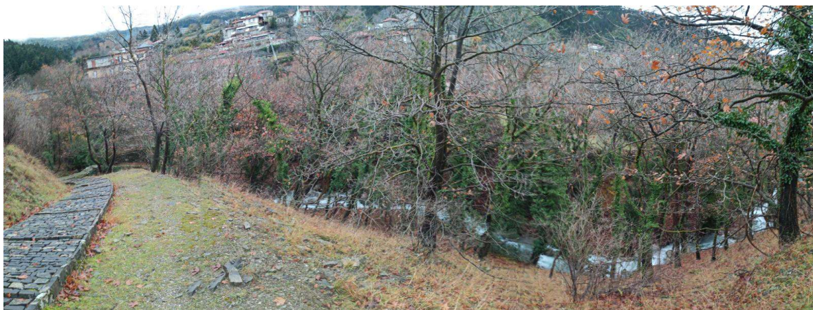
Φωτ. 8: Πανοραμική άποψη του πέτρινου γεφυριού σε σχέση με το ρέμα (διακρίνεται το ρέμα σε απόσταση από το πέτρινο γεφύρι)
